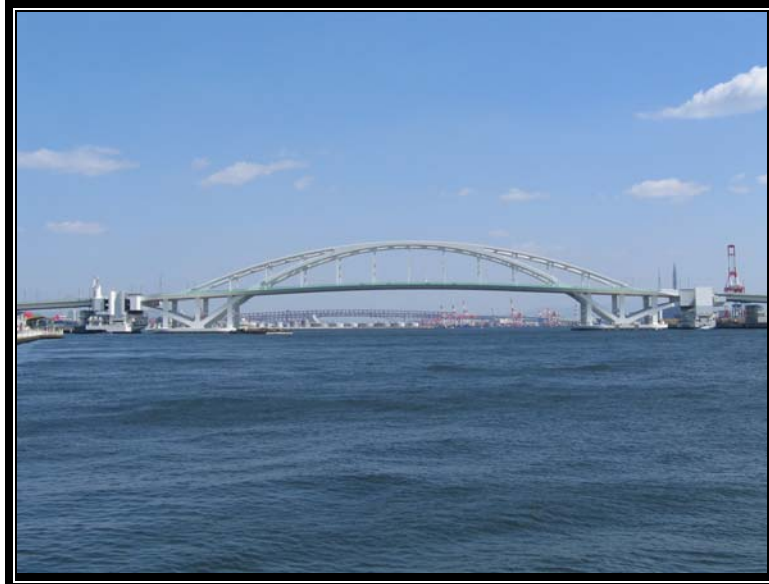
Fig. 6 Yumemai Bridge, Japan
